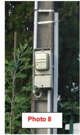
Compteur extérieur apparent
